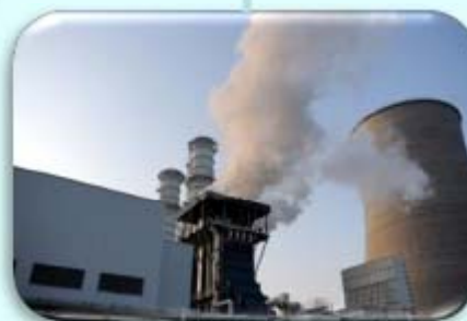
垃圾焚烧 生物质电站
