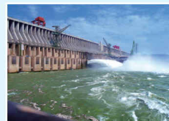
世界第三大水电站—古里水电站
